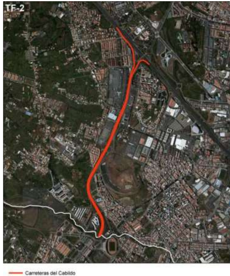
Imagen nº 6: Tramo de la carretera TF-2 dentro del municipio de La Laguna
