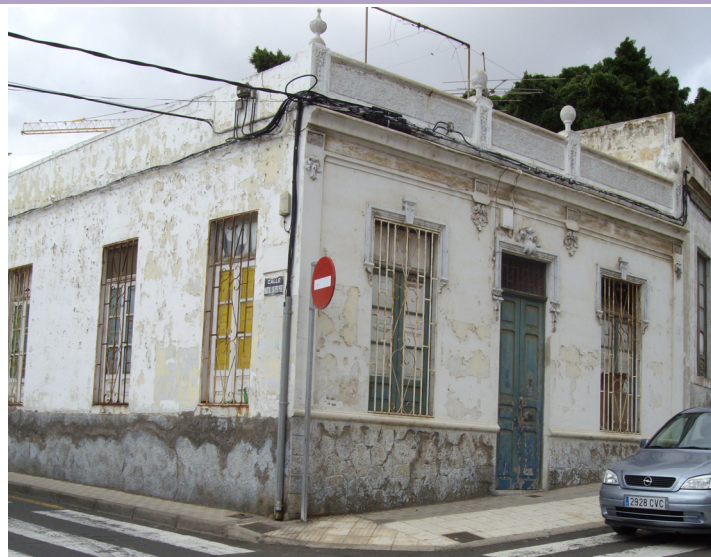
Fotografía del inmueble
