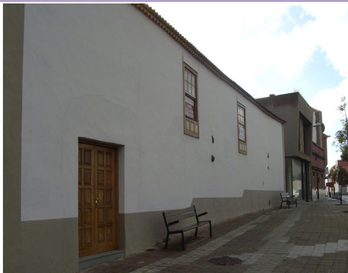
Fotografía del inmueble
