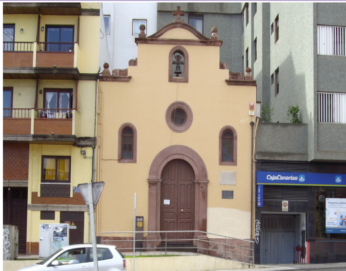
Fotografía del inmueble
