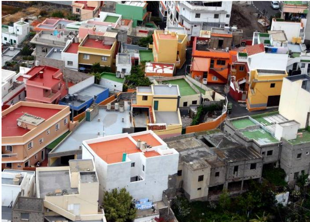
Figura 4.2: Edificación existente, con problemas de habitabilidad y accesibilidad.
