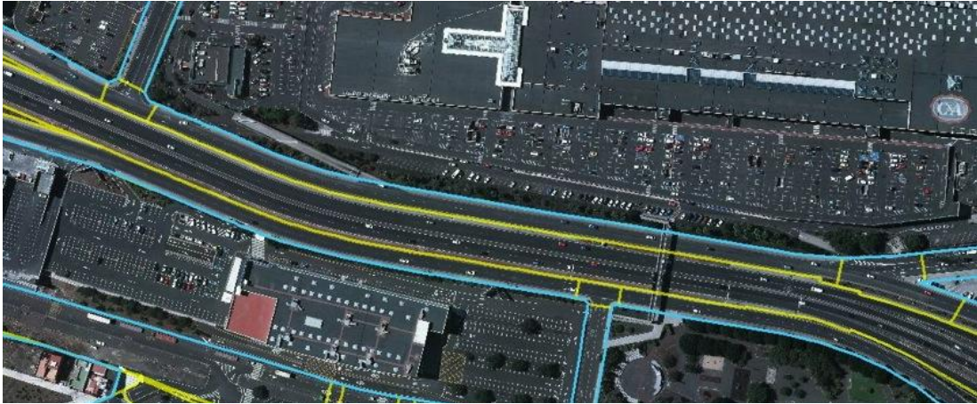
Figura 7: Las dos vías de servicio de la TF2 son tramos viarios distintos del tronco central de la autovía
