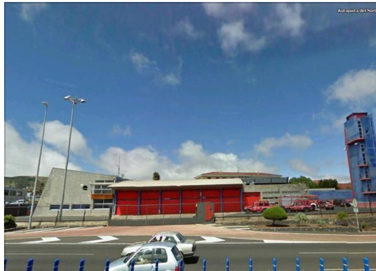
Figura 7: Estación de bomberos
