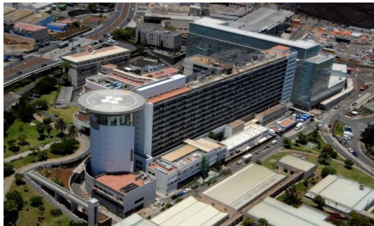
Figura 8: Hospital Universitario de Canarias
