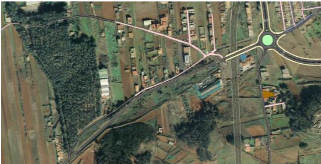
Figura T1-34: Carretera de La Esperanza
