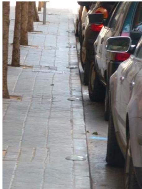
Foto nº 3: Sensores instalados en el bordillo
