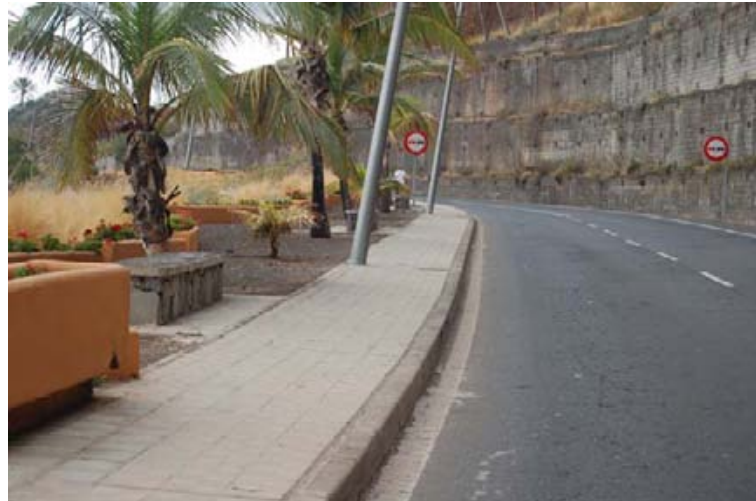
Foto nº 8: Desplazamiento de las luminarias hacia la zona ajardinada facilitando el tránsito de peatones.
