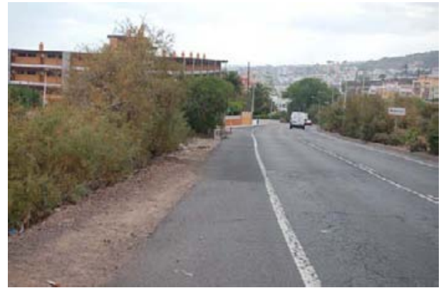
Foto nº 12: Tramo de la TF-13 entre Bajamar y Tejina sin acerado.
