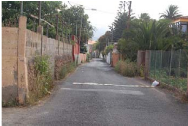
Foto nº 11: Tramo de Paseo Concepción Salazar sin acerado.
