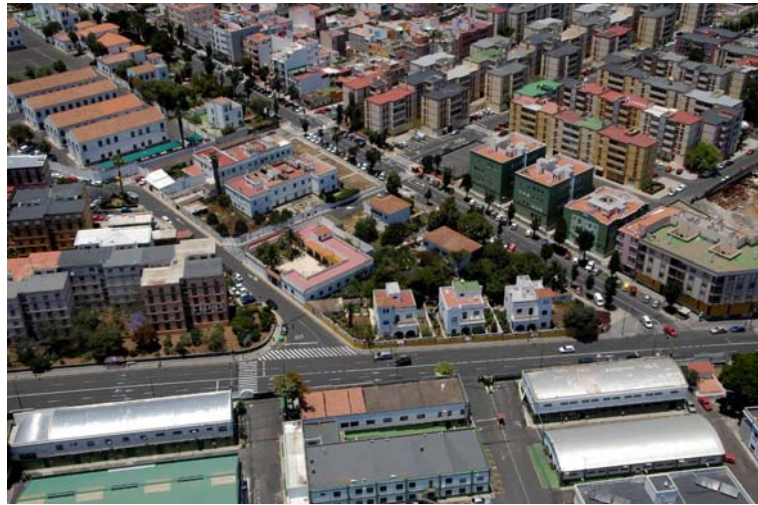
Imagen nº 22: Tramo de La Cuesta antes de las obras de implantación de la línea 2 del tranvía.
