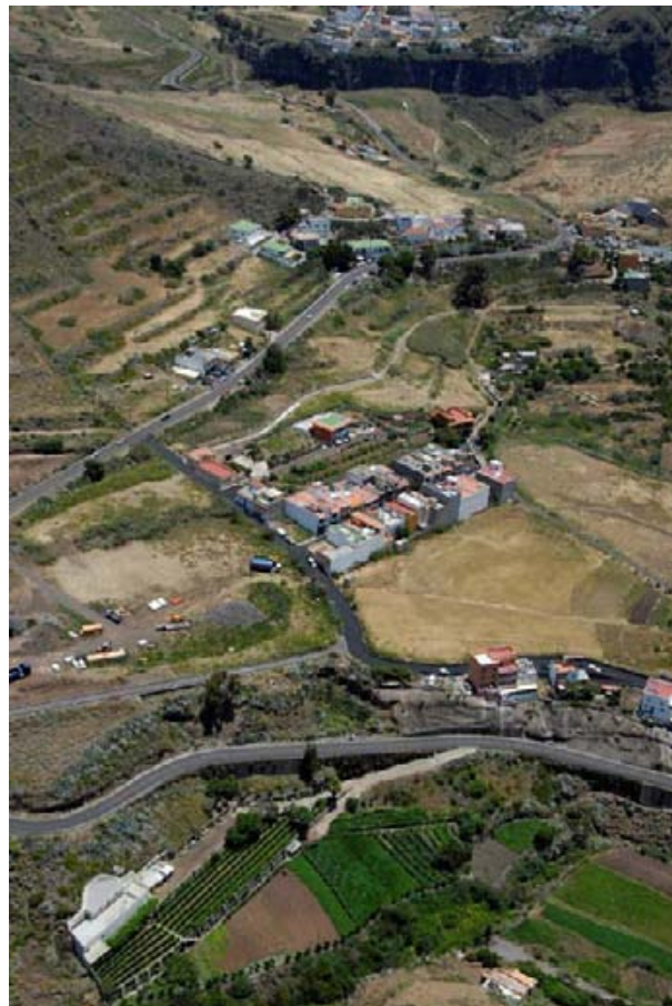
Imagen nº 11: Carretera TF-111 en el entorno de Valle Tabares.
