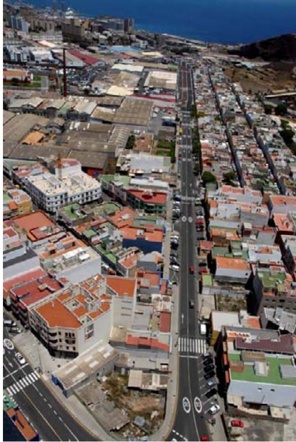
Imagen n° 24: En la zona de Taco, la integración entre vía, aparcamiento y edificación no es adecuada.
