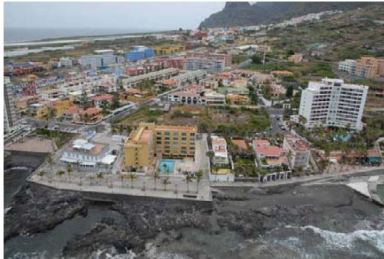
Imagen nº 33: Vista desde el borde costero de la urbanización turística y residencial de la Punta del Hidalgo.
