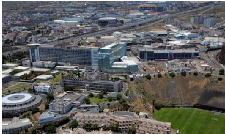
Imagen nº 61: Vista general del complejo del Hospital Universitario.
