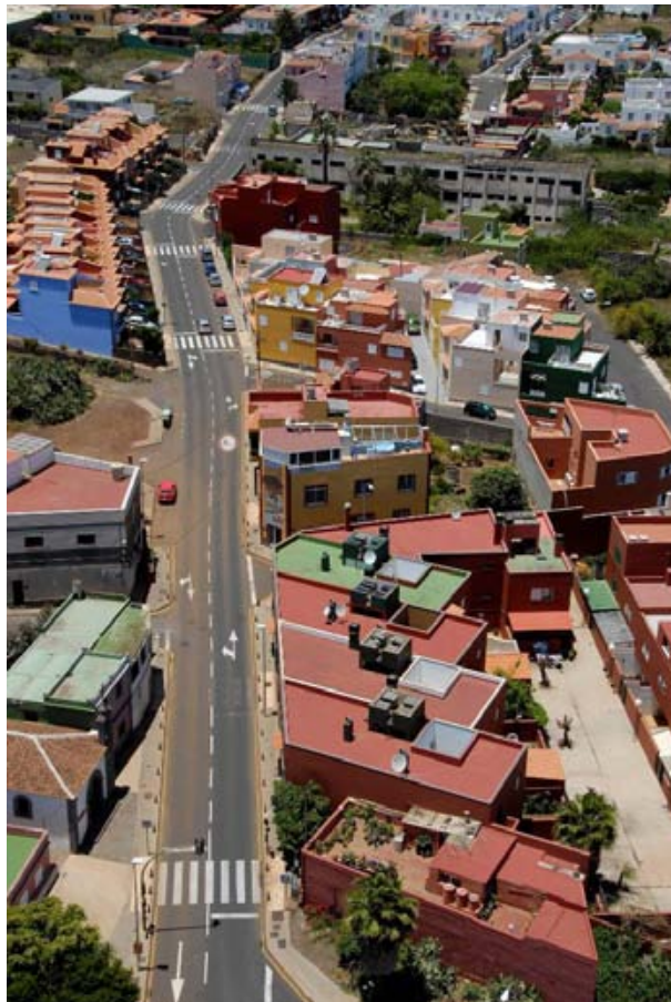
Imagen nº 27: Tramo del camino de San Bartolomé de Geneto con los aparcamientos discontinuos y una disposición excesiva de pasos peatonales.
