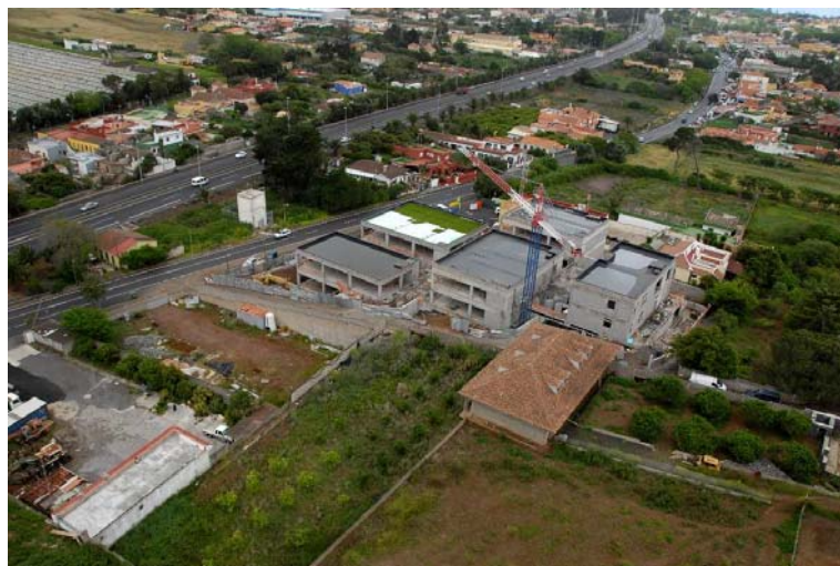
Imagen nº 20: La carretera TF-152 en el entorno de Guamasa, zona en la que se están desarrollando actividades en los márgenes que requieren de una transformación de la vía.
