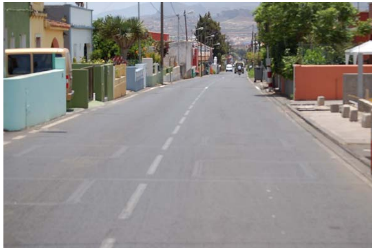
Imagen n° 81: Vista de la TF-113 en el entorno al acceso al CPEIPS Drecroly.
