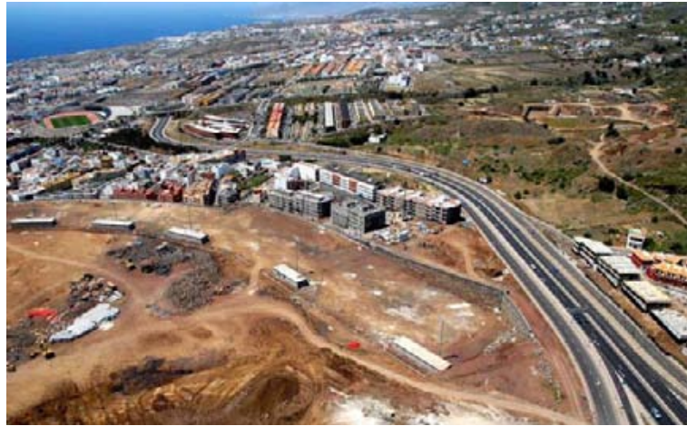
Imagen nº 2: La TF-2 en Los Andenes. A pesar de las vías de servicio, las edificaciones entran en conflicto con la vía.
