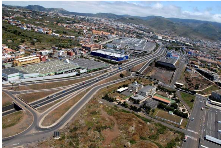
Imagen nº 55: Parte del Polígono de Los Majuelos en la zona inferior de Guajara.
