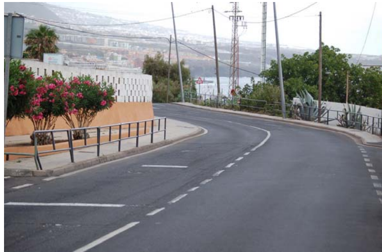
Imagen nº 79: Tramo de la TF-13 previo al acceso al CEIP La Punta.
