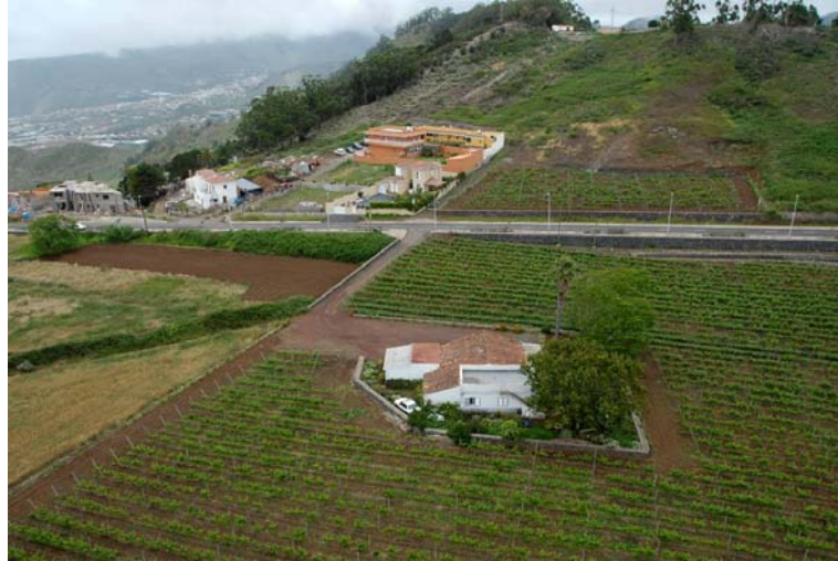
Imagen n° 13: Tramo de la TF-156 con tratamiento "urbano" en el entorno a Guamasa.
