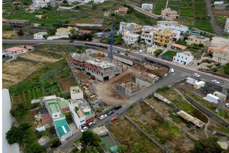
Imagen nº 9: Tramo final de la TF-16 en La Laguna, cerca de la intersección con la TF-156.
