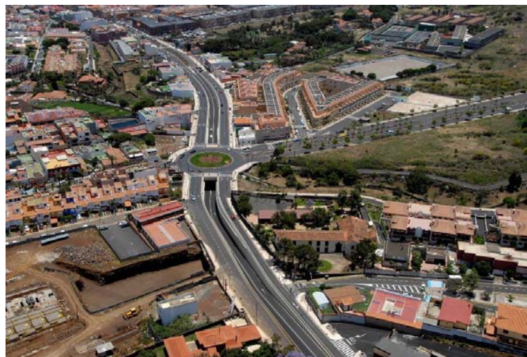
Imagen nº 19: Intersección entre las Avenidas de Los Menceyes (longitudinal), Las Palmeras y César Manrique.
