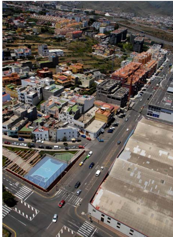
Imagen nº 26: Vista de la Avenida El Paso desde la intersección con la Avenida de la Libertad. Se observa la falta de homogeneidad de la sección transversal de esta vía.
