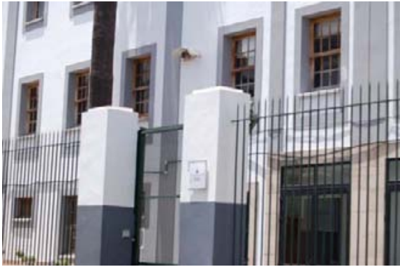
Foto nº 5: Entrada al IES Canarias Cabrera Pinto. Edificio Nuevo.
