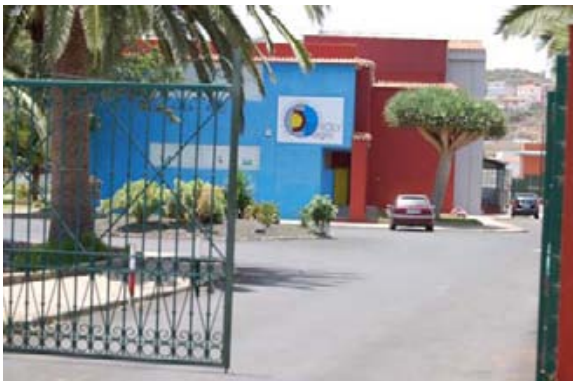
Foto n° 3: Entrada de acceso al CPEIPS Decroly.
