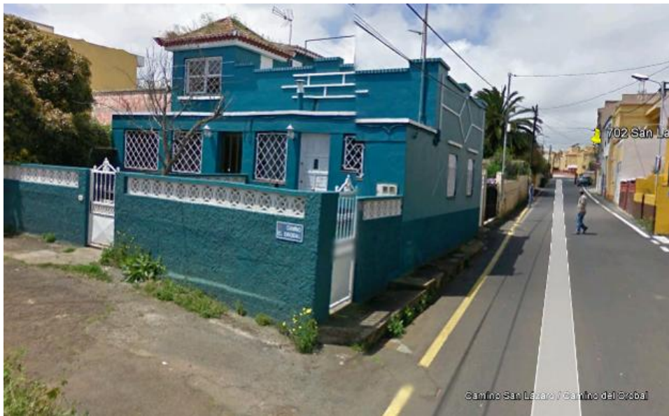
Figura 6: Avance de la edificación hacia el Camino San Lázaro
