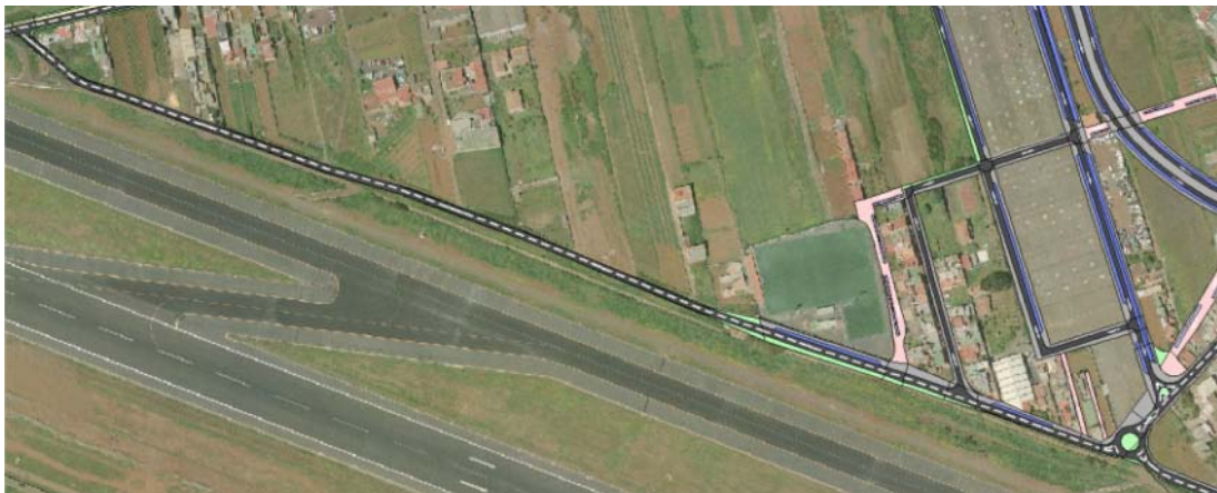
Figura R5: Tramo R02-01
