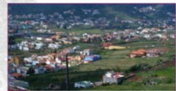
5 Impacto paisajístico por la falta de definición del borde urbano, junto a la falta del remate de las fachadas traseras asomadas al suelo rústico.
