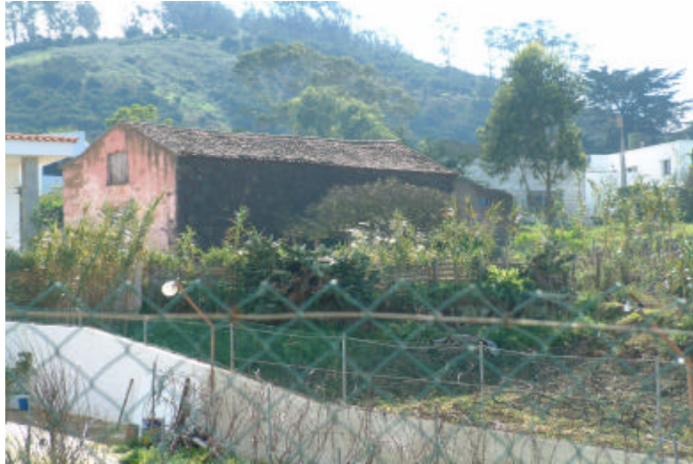
Foto 1-Medidas Correctoras: Estado actual de la edificación propuesta para su inclusión dentro del Catálogo.
