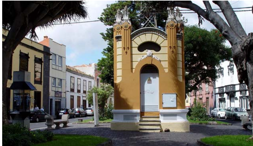
Torreones de Transformación Eléctrica
